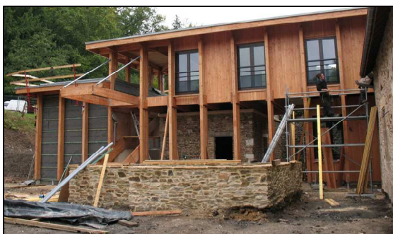
Construction châtaignier : Maison du Parc-©pnrpl
